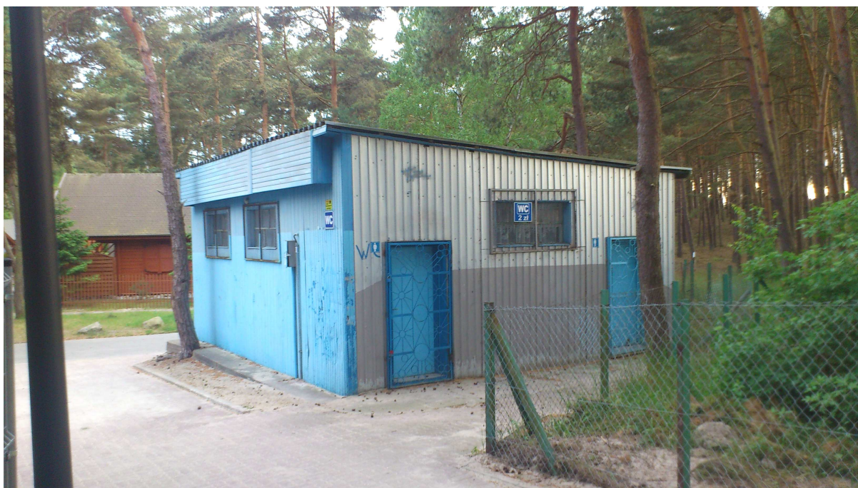
Widok od strony północno-wschodniej
