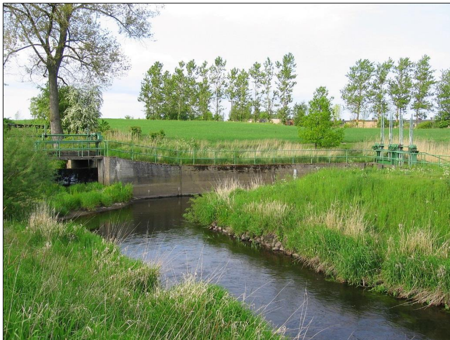
Fot. 3 Śluzka Łuzanki, gdzie bierze początek od Dębosznicy
