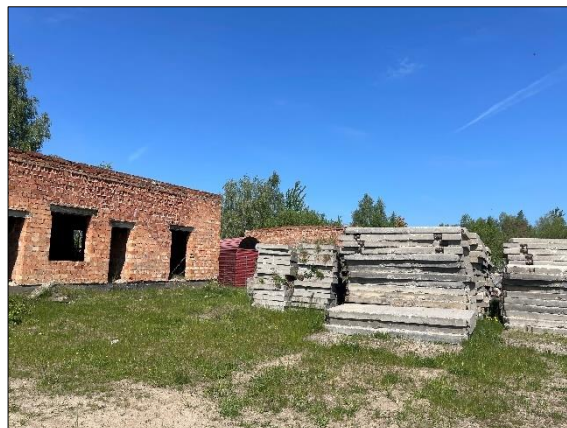
Fot. 2 Istniejące zainwestowanie na dz. nr 260/1 Źródło: archiwum własne
