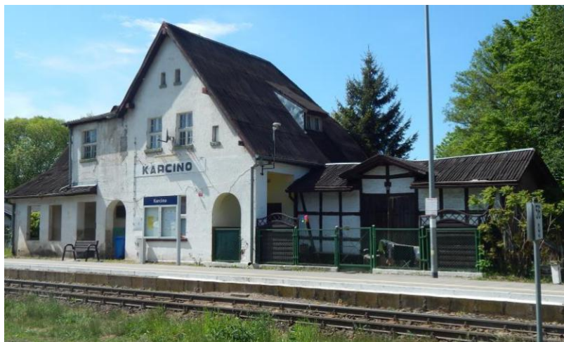
Stacja kolejowa w Karcinie
