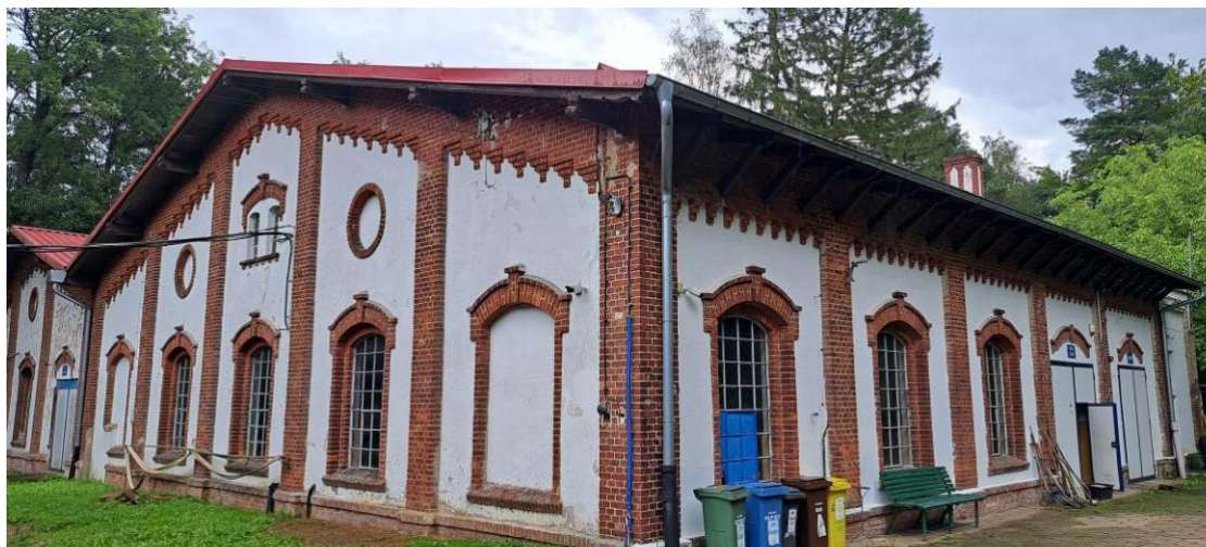
Hala pomp w Kopydłównie
