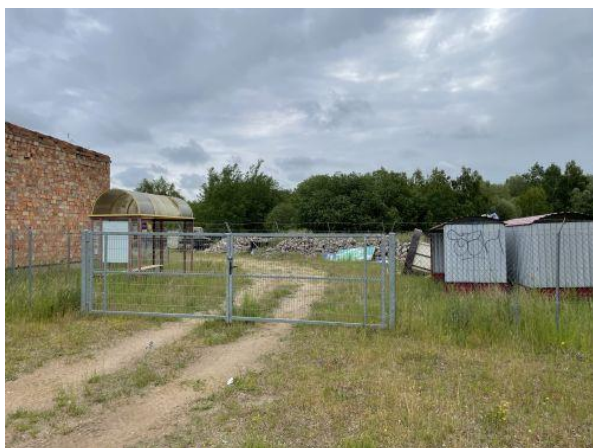
Fot. 4. Brama wjazdowa na teren składowiska odpadów komunalnych w Nowogardku
