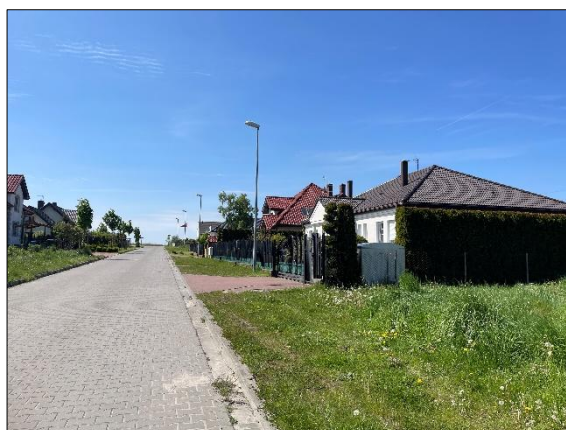
Fot. 6 Zabudowa mieszkaniowa przy ul. Wiśniowej Źródło: archiwum własne
