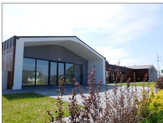
Fot. 1 Istniejący budynek usługowy na dz. nr 131/54 Źródło: archiwum własne
