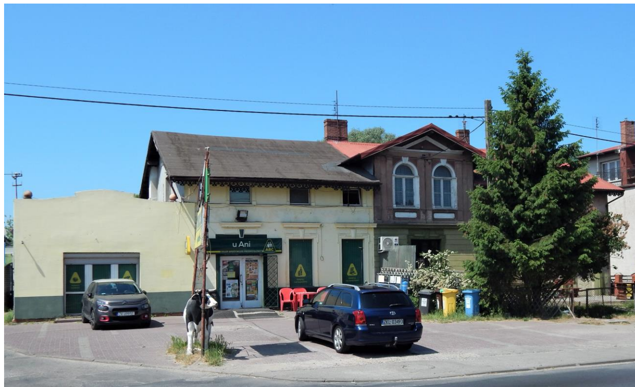
Elewacja frontowa. Widok od wschodu
