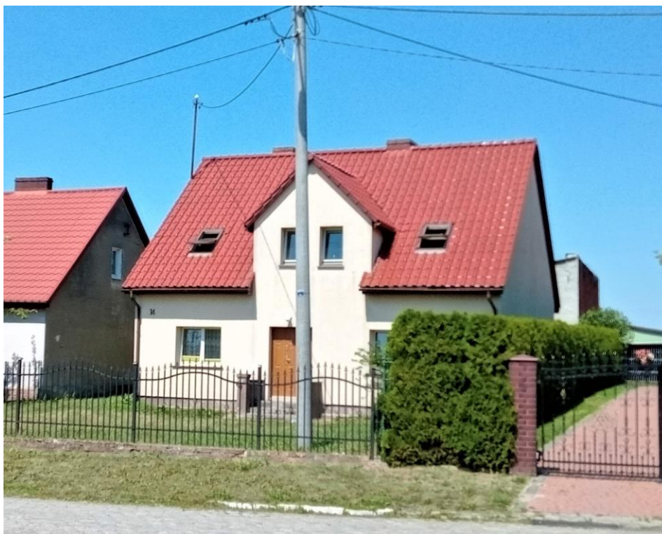
Elewacja frontowa. Widok od południa
