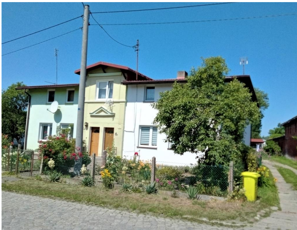
Elewacja frontowa. Widok od południa
