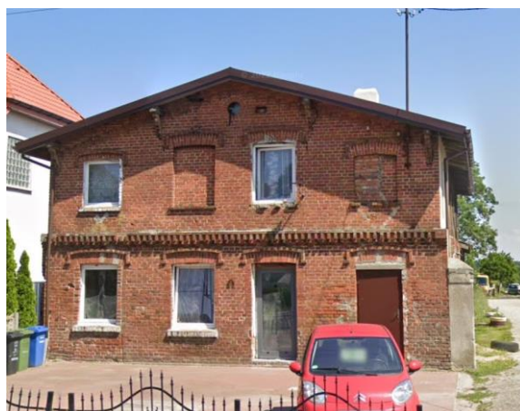
Elewacja szczytowa. Widok od zachodu
