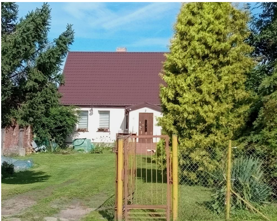
Elewacja fontowa. Widok od południa
