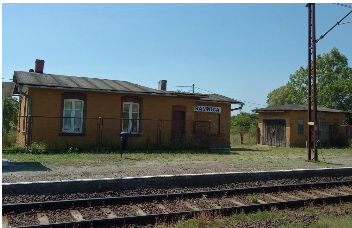
Elewacja frontowa. Widok od północnego wschodu
