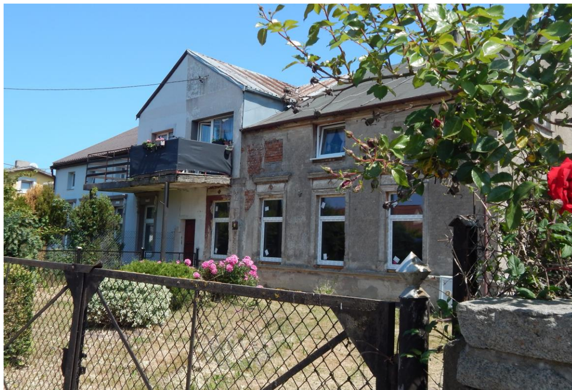
Elewacja frontowa. Widok od południowego zachodu
