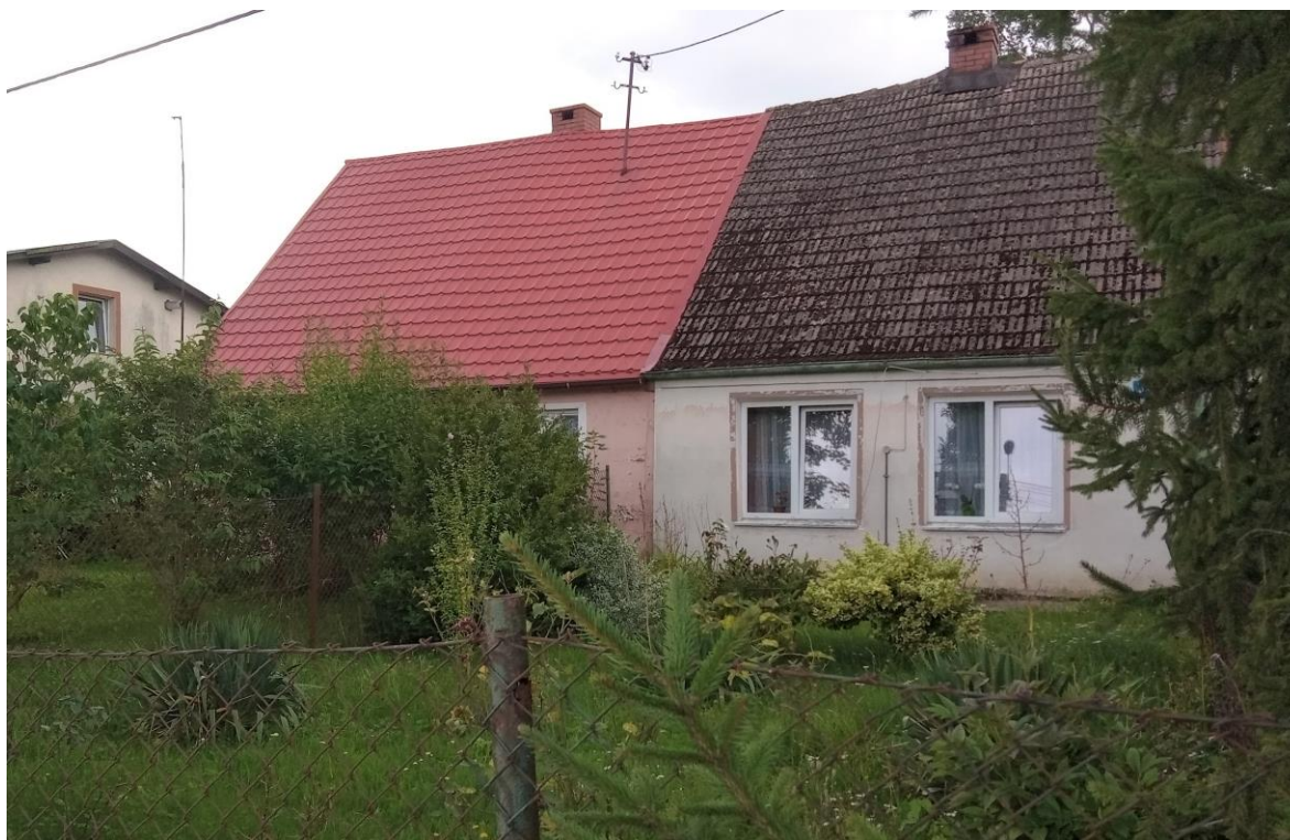
Elewacja frontowa. Widok od wschodu
