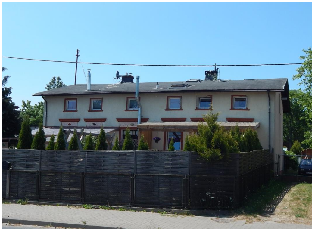
Elewacja od frontu. Widok od wschodu
