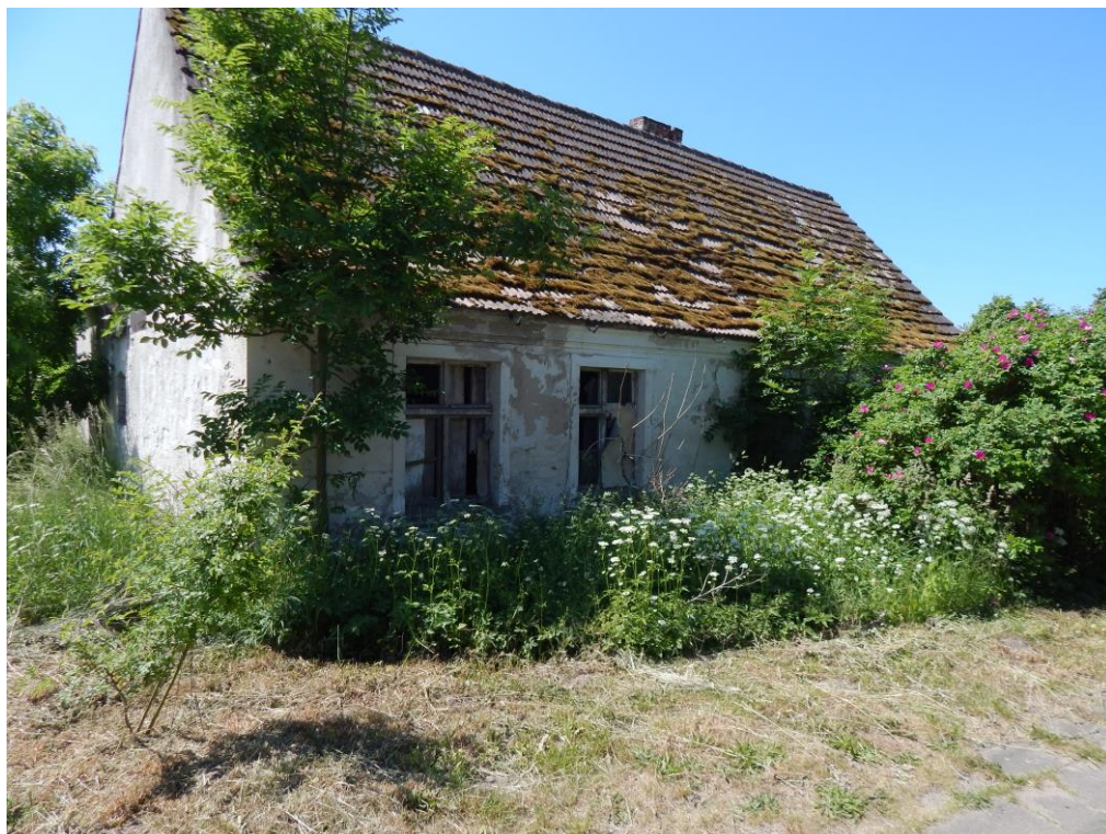
Elewacja frontowa. Widok od północnego wschodu
