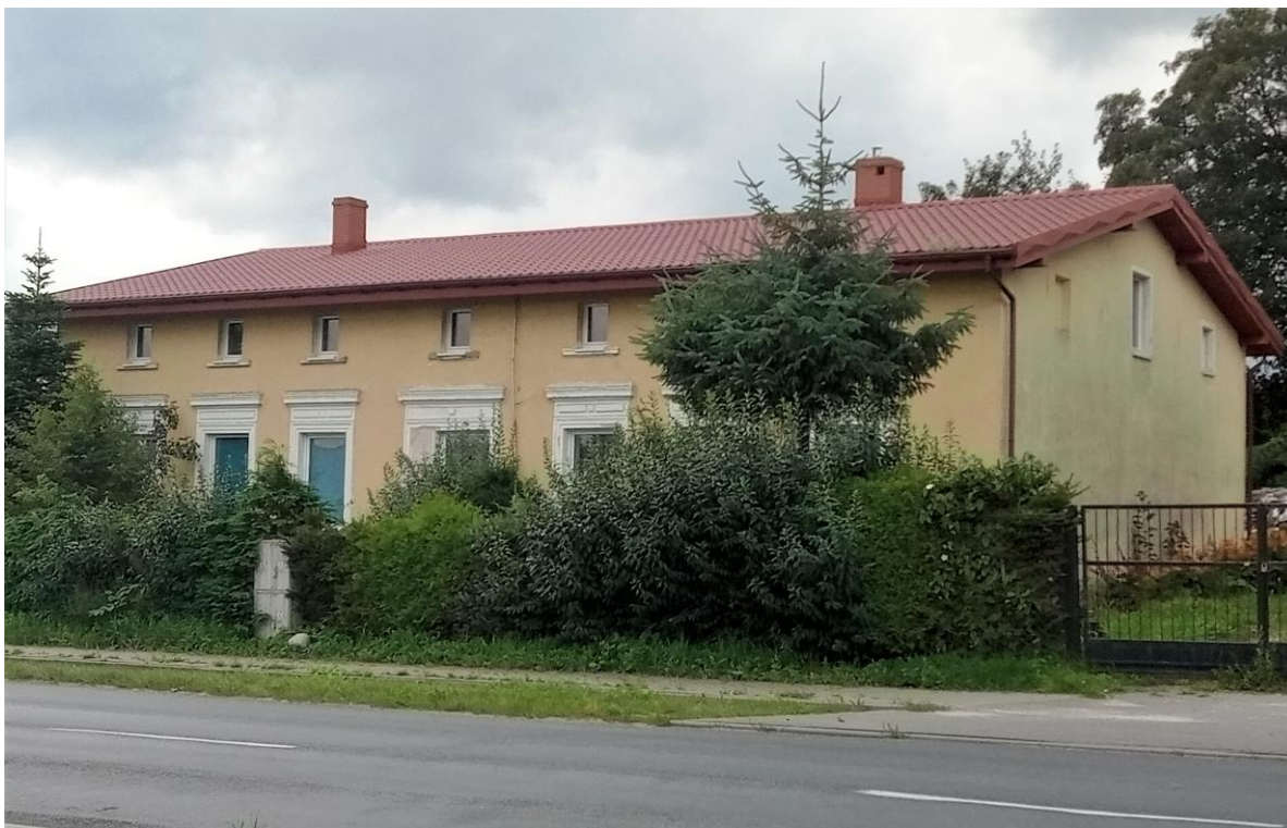
Elewacja frontowa. Widok od wschodu
