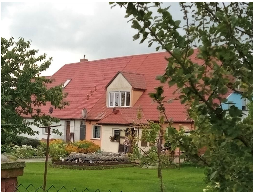
Elewacja frontowa. Widok od wschodu
