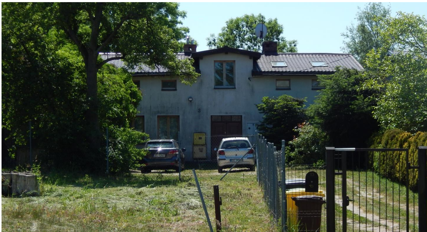
Elewacja frontowa. Widok od północnego wschodu
