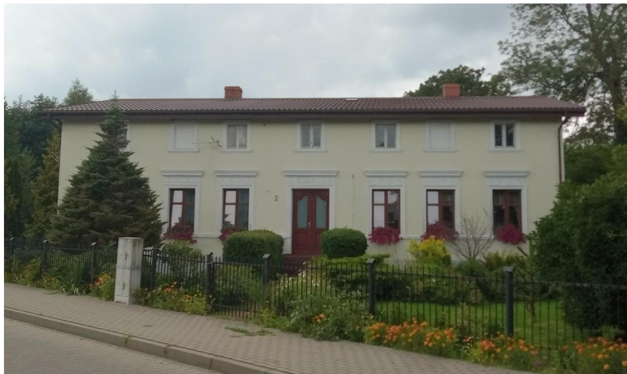
Elewacja frontowa. Widok od wschodu
