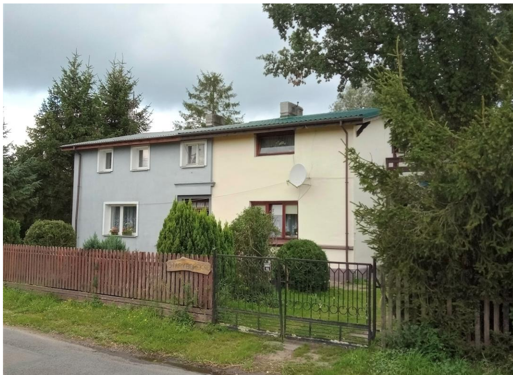
Elewacja frontowa. Widok od południa
