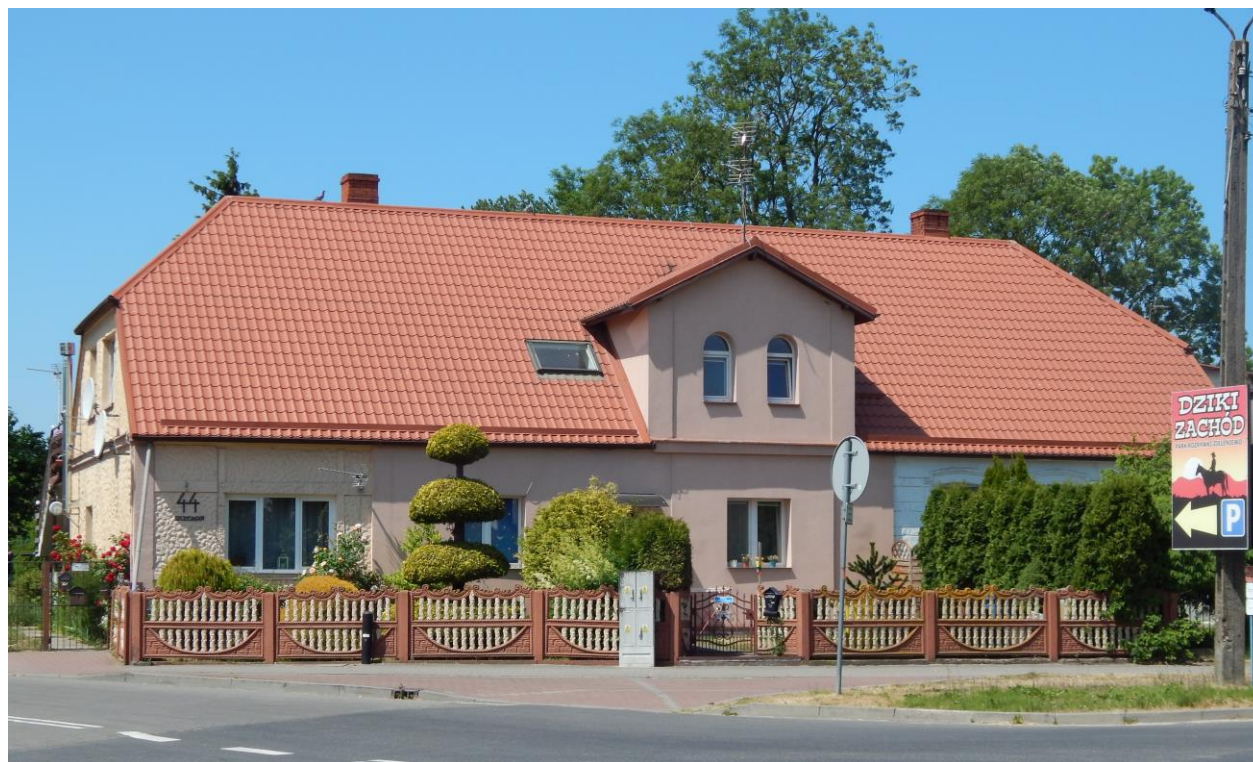
Elewacja frontowa. Widok od wschodu
