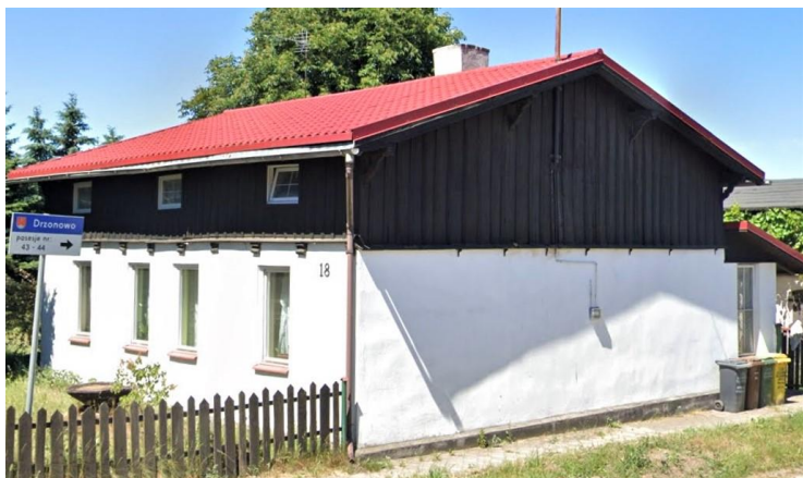
Elewacja frontowa i szczytowa. Widok od południowego wschodu
