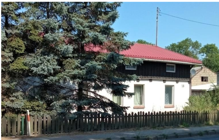
Elewacja frontowa. Widok od południa
