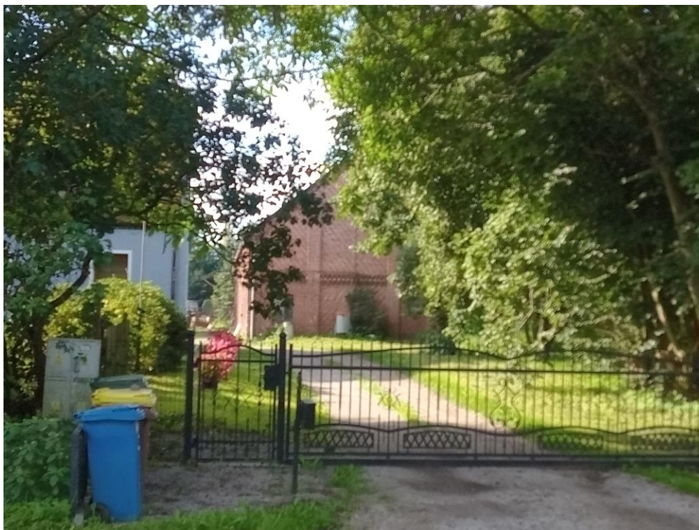
Budynek inwentarski. Widok od północy
