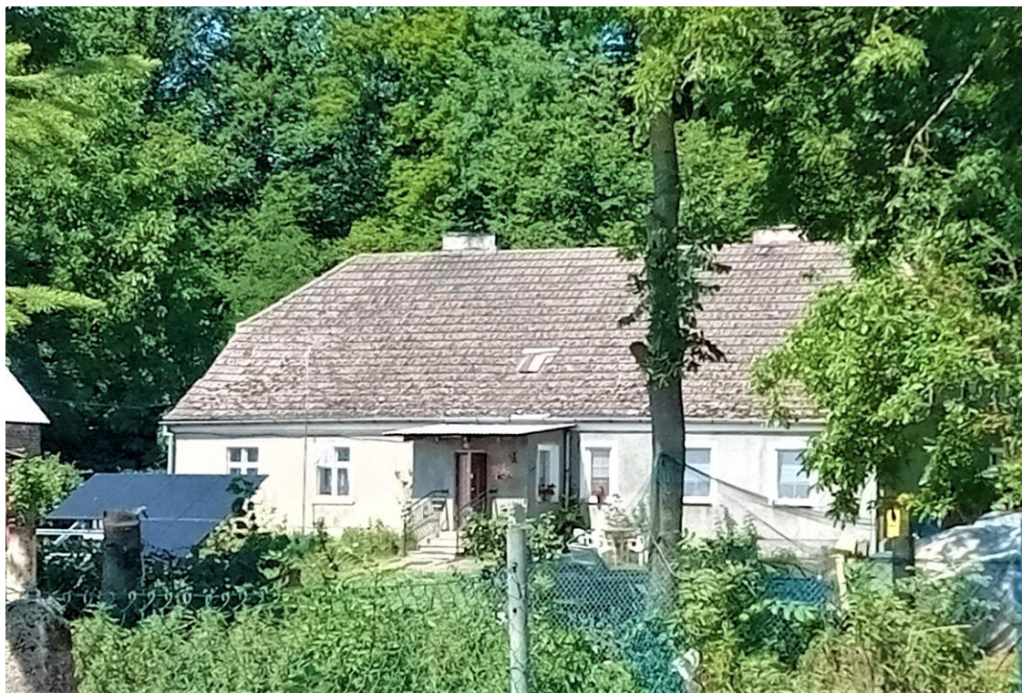
Elewacja frontowa. Widok od południa
