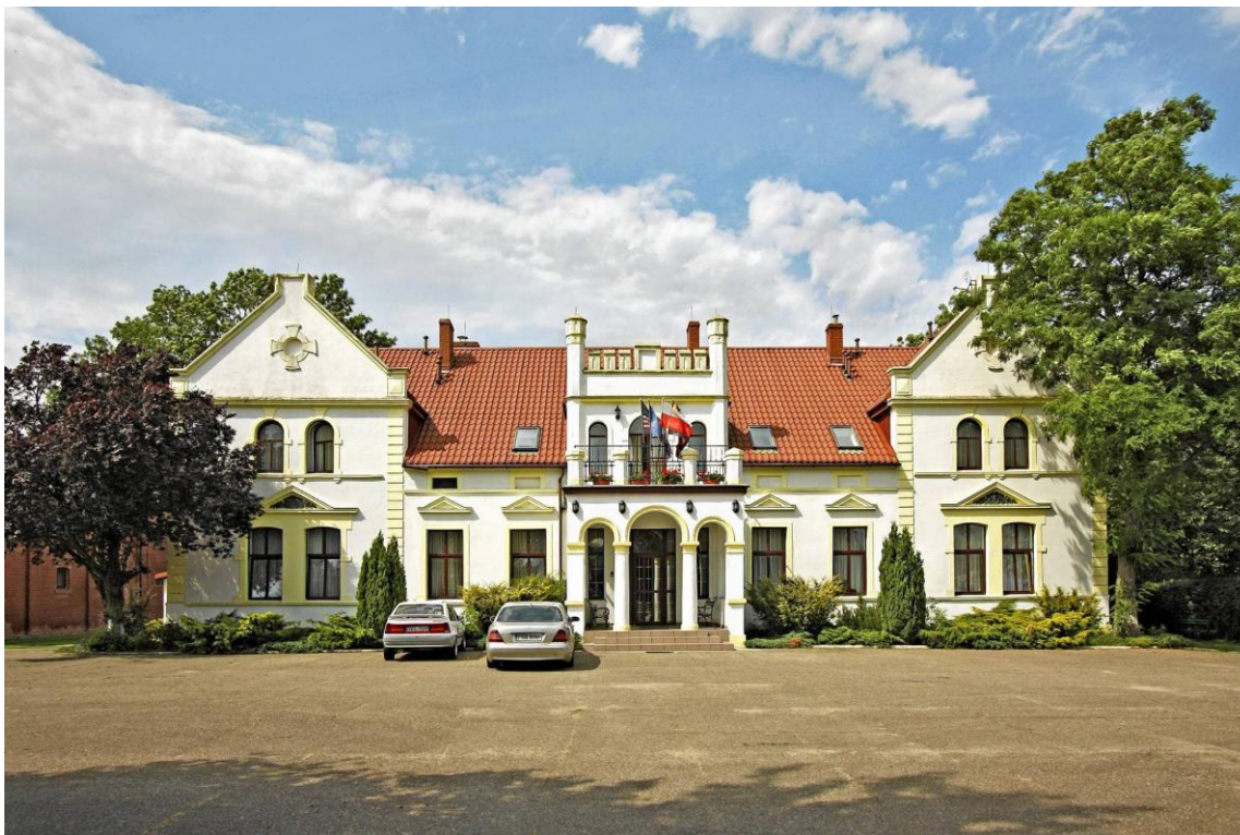
Elewacja frontowa. Widok od wschodu
