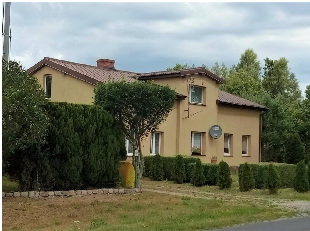
Elewacja frontowa. Widok od południa
