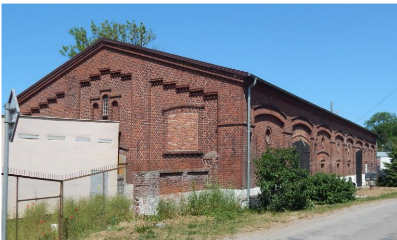
Elewacja szczytowa i frontowa. Widok od południowego wschodu
