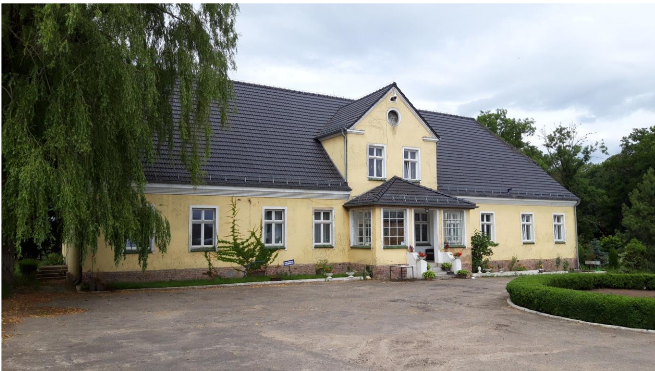
Elewacja frontowa. Widok od wschodu
