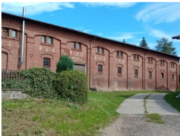
Elewacja boczna. Widok od południowego zachodu
