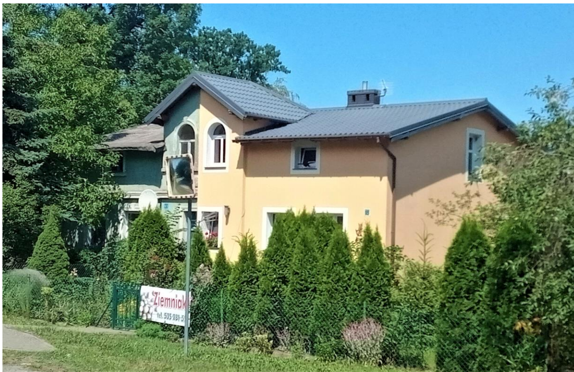
Elewacja frontowa i szczytowa. Widok od południowego wschodu
