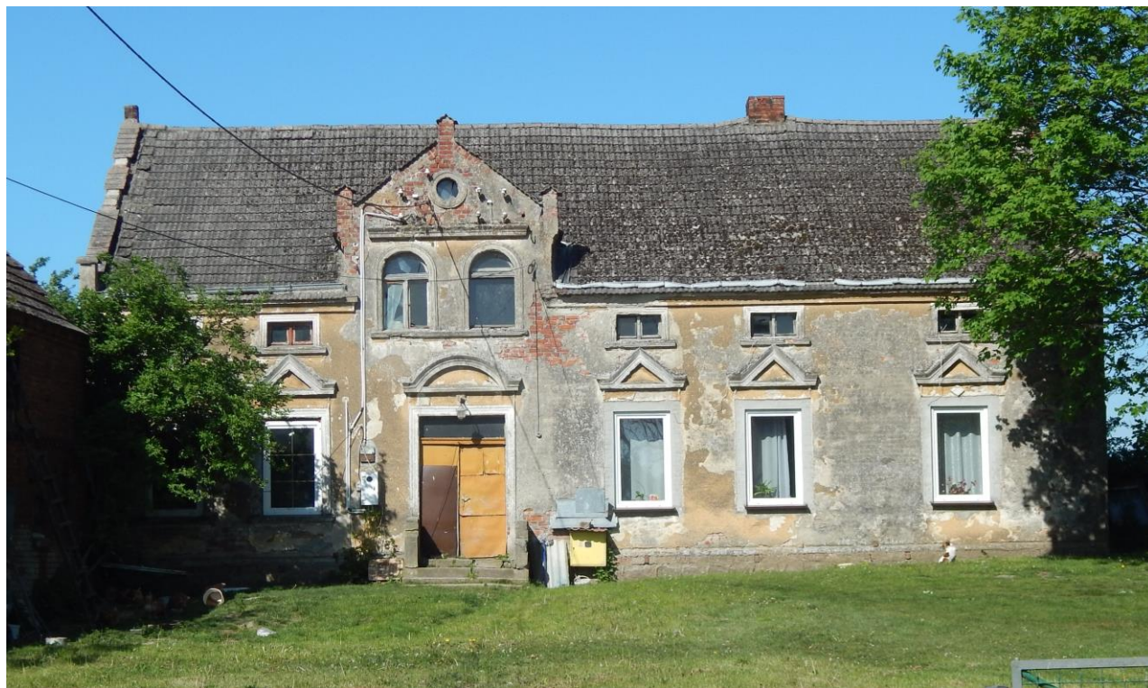
Elewacja frontowa. Widok od południowego zachodu
