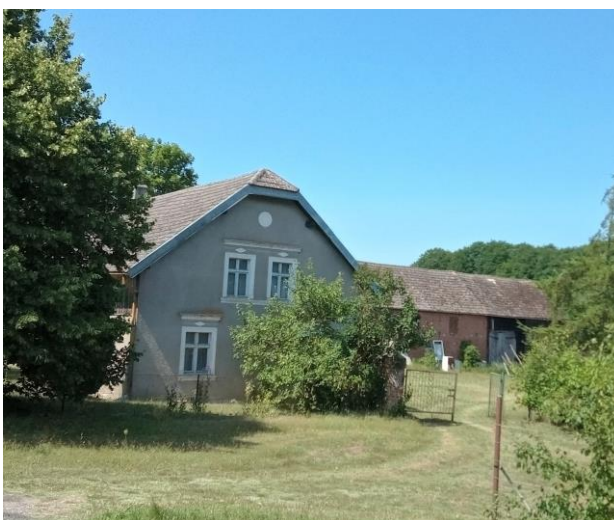
Elewacja szczytowa. Widok od wschodu
