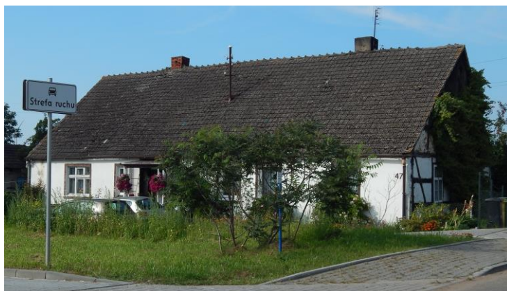
Elewacja frontowa. Widok od południa
