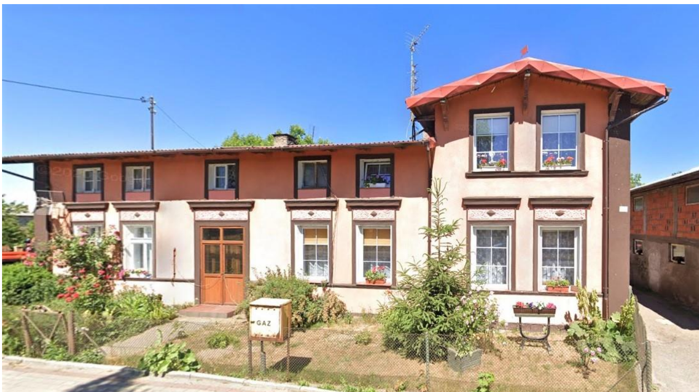
Elewacja frontowa. Widok od południa
