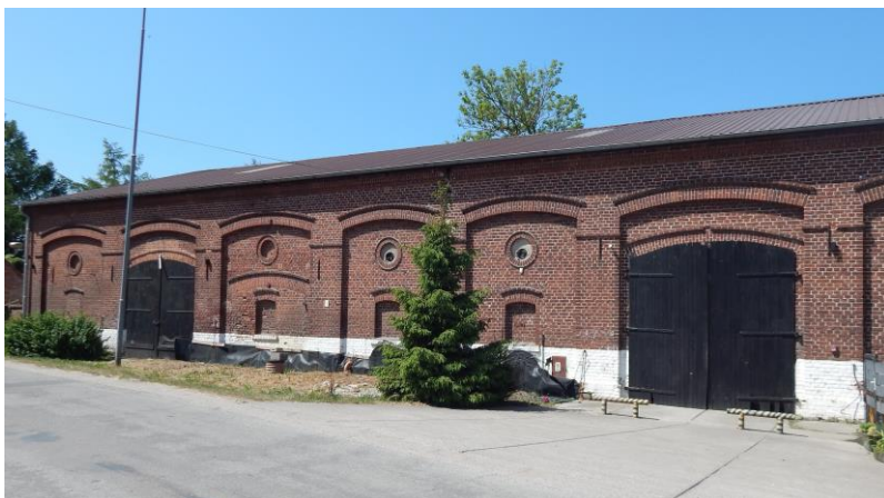
Elewacja frontowa. Widok od wschodu
