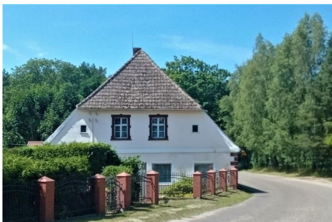
Elewacja Szczytowa. Widok od wschodu
