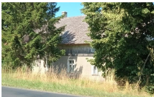
Elewacja frontowa. Widok od południa
