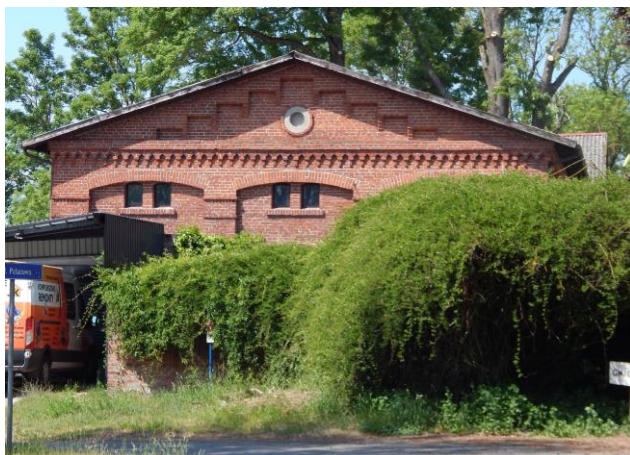
Elewacja szczytowa. Widok od wschodu
