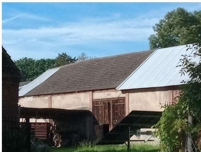
Stodoła. Widok od północnego wschodu
