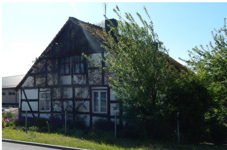
Elewacja szczytowa. Widok od wschodu
