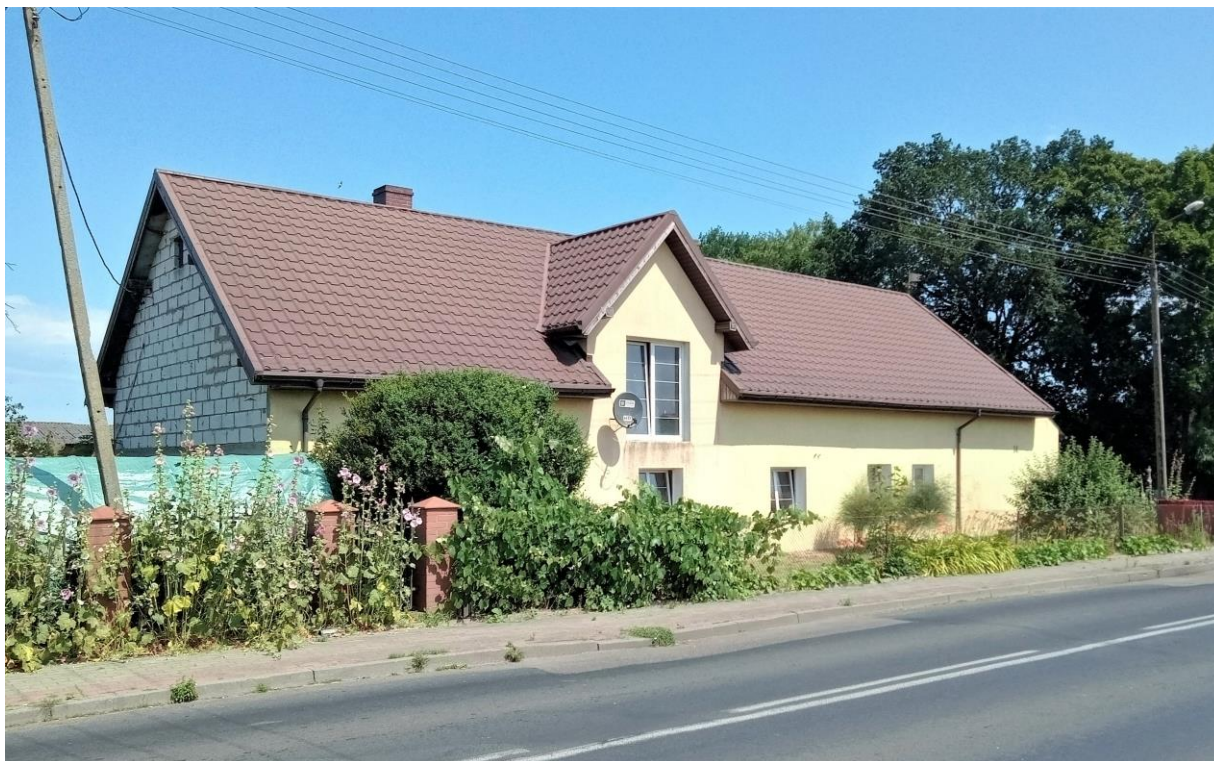
Elewacja frontowa. Widok od południowego zachodu
