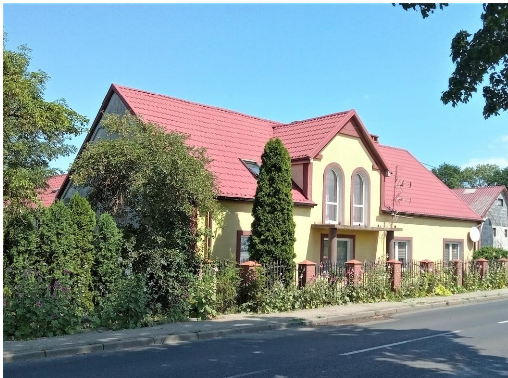
Elewacja frontowa. Widok od południowego zachodu
