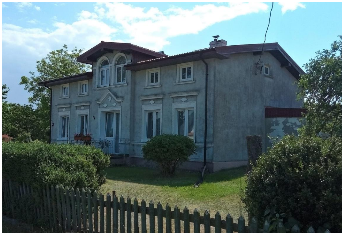
Elewacja frontowa i szczytowa. Widok od północnego zachodu
