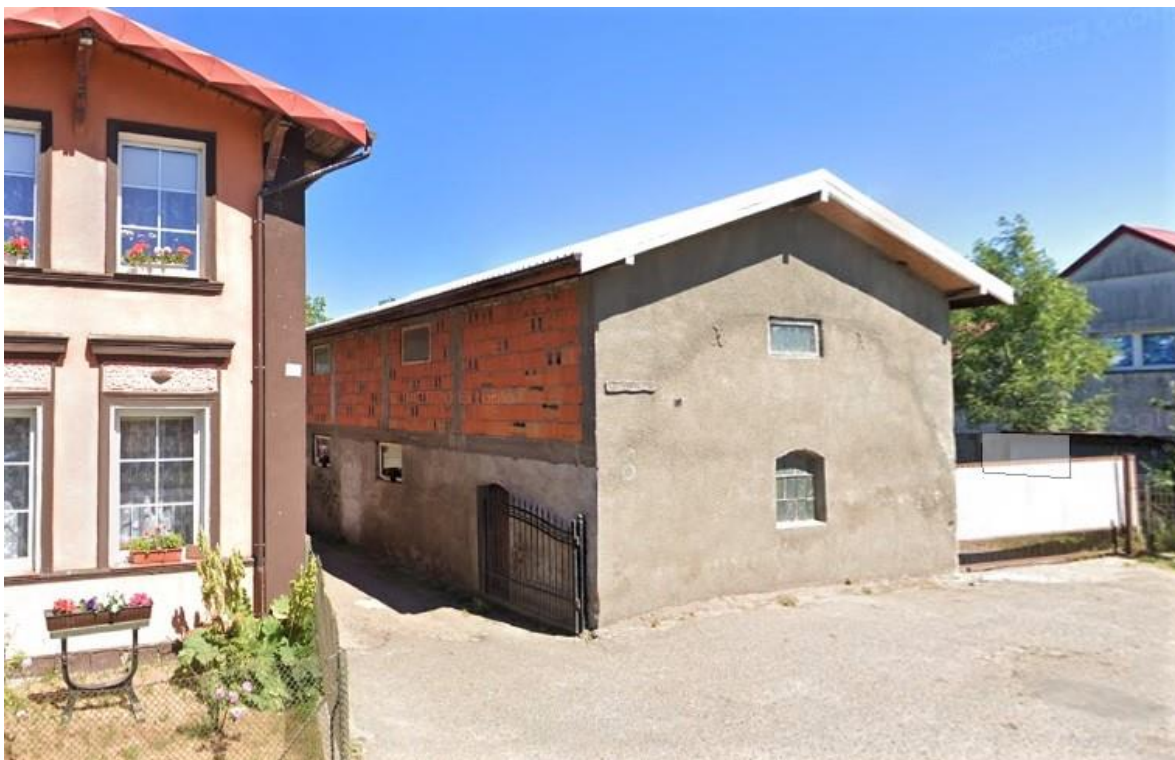
Elewacja szczytowa i boczna. Widok od południowego zachodu
