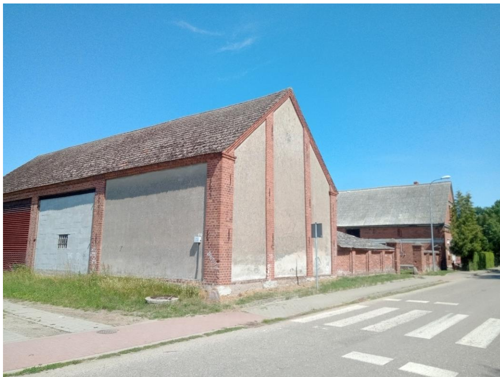
Elewacja szczytowa i boczna. Widok od południowego zachodu.
