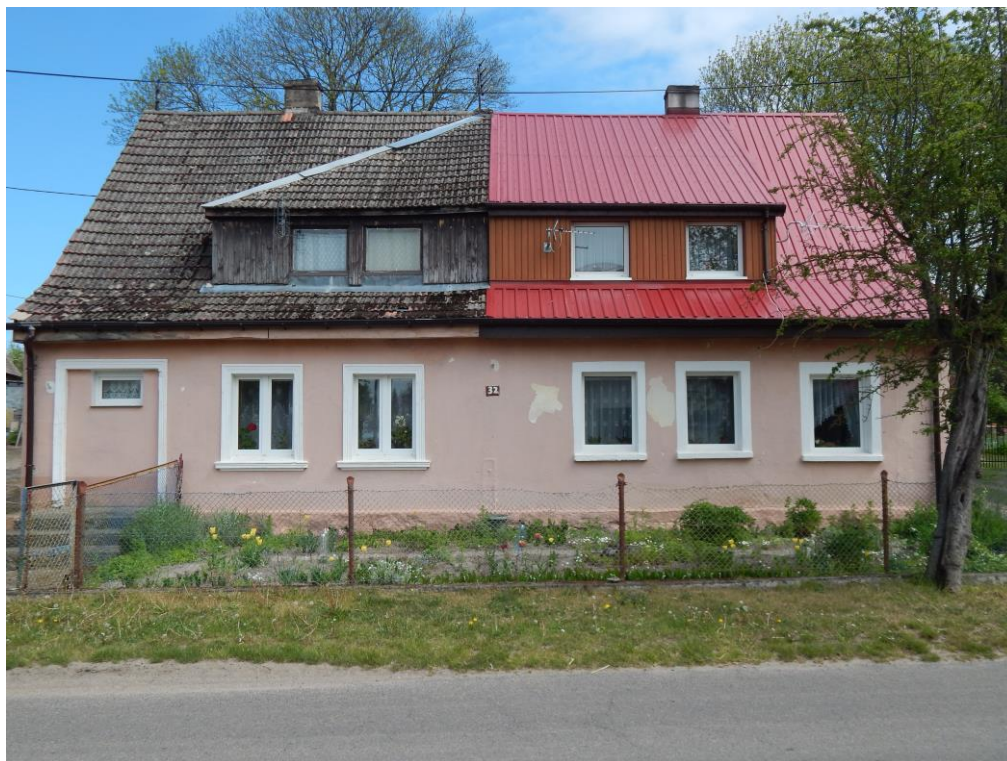
Elewacja frontowa. Widok od południowego zachodu
