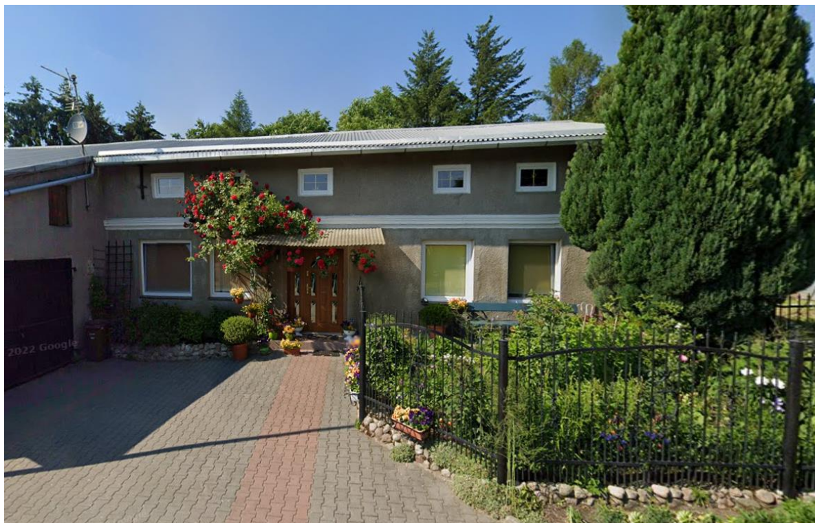
Elewacja frontowa. Widok od południa
