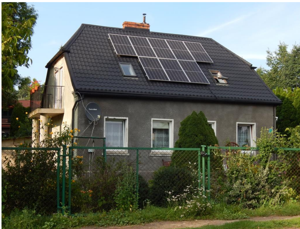
Elewacja frontowa. Widok od południa
