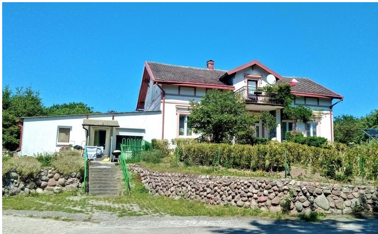
Elewacja frontowa. Widok od południa
