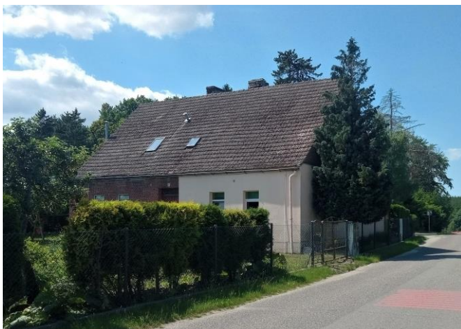
Elewacja frontowa. Widok od wschodu
