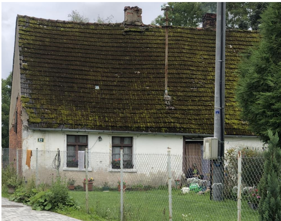
Elewacja frontowa. Widok od północnego wschodu
